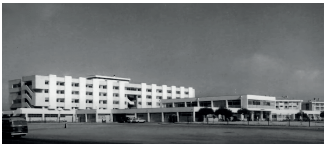
Fig. 3. Consultorio Externo y Torre de Hospitalización, Hospital de Coquimbo, Sociedad Constructora de Establecimientos Hospitalarios. Carretera Panamericana con Avenida Nolasco Videla s/n, Coquimbo, Chile, 1970-1976. Colección personal de Logan Leyton.
