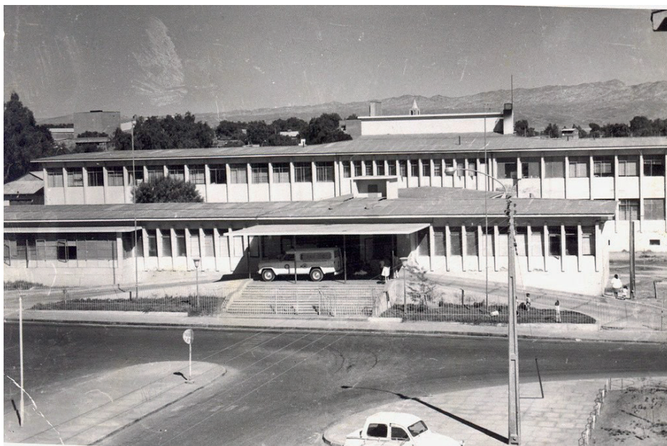
Fig. 3. Francisco Fones, Hospital Carlos Cisterna, Calama, 1964, la fotografía fue tomada a principio de los 70'. © Lucas Burchard S.
