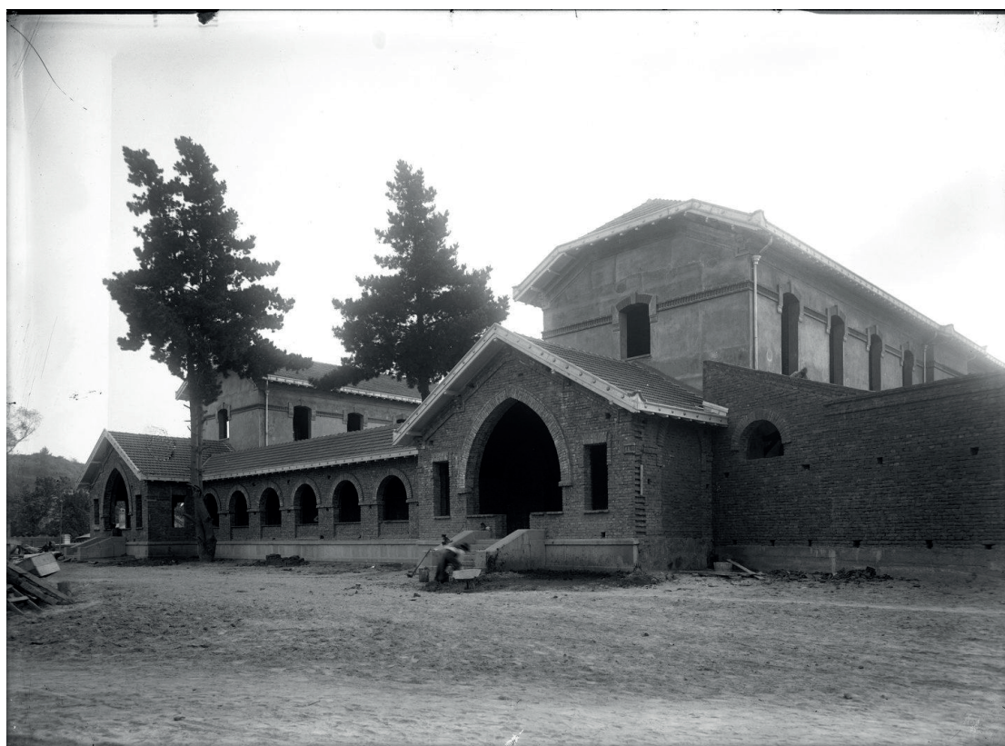
Figura 3. Emilio Doyère, Manicomio Avello, Concepción, Chile, 1917 - 1929, Fotografía construcción de uno de los pabellones del manicomio. © Créditos Archivo Fotográfico de la Dirección de Arquitectura del Ministerio de Obras Públicas.io de Salud.
