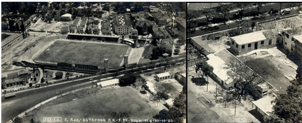
Figura 2. Avenida Venceslau Brás e o edifício do Instituto de Neurologia em obras no detalhe. © Escola de Aeronáutica / Museu Aeroespacial, 1950.
