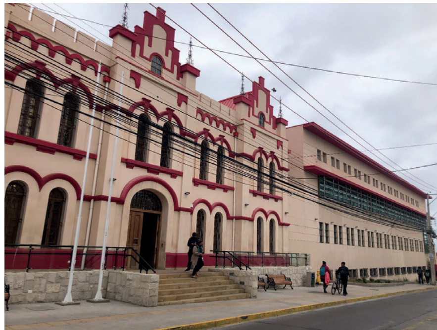
Fachada patrimonial por calle Anfión Muñoz (corresponde al antiguo acceso de la ex cárcel)
